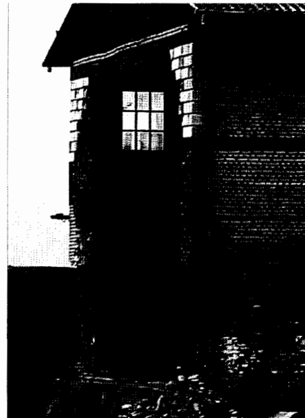
Rys. 13. Zawalona ściana spichlerza zbożowego w Dąbrówce Małej. Nie ma stuprocentowej pewności, czy zjawisko to można uznać za pośredni efekt wstrząsów sejsmicznych z 21 września 2004 r.
